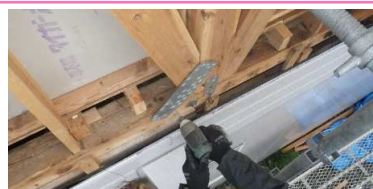
耐震の金具を設置する様子
