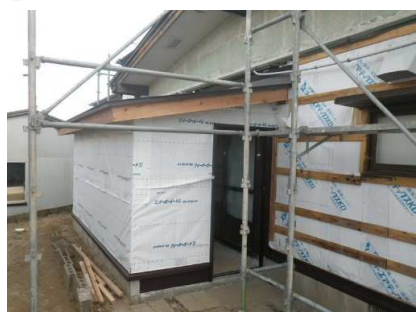
断熱・防水工事
