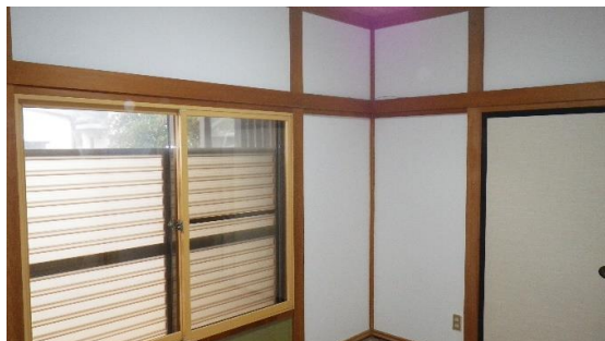
内窓の取付け
