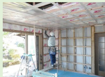
天井・壁断熱
