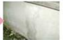
ひび割れの補修後
