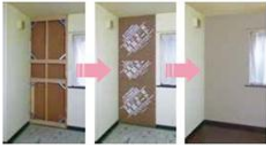
床・天井を残したまま補強する方法
