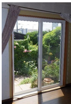
断熱サッシに交換
