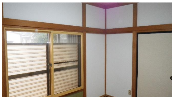
内窓の取付け
